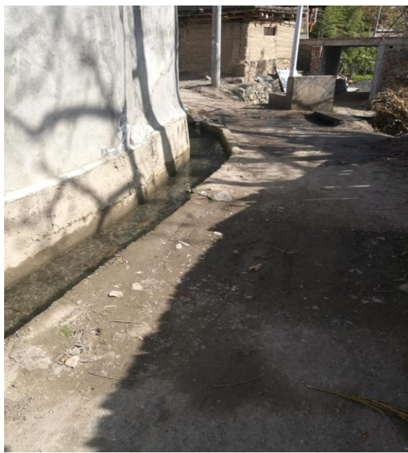
现有道路及排水现状
