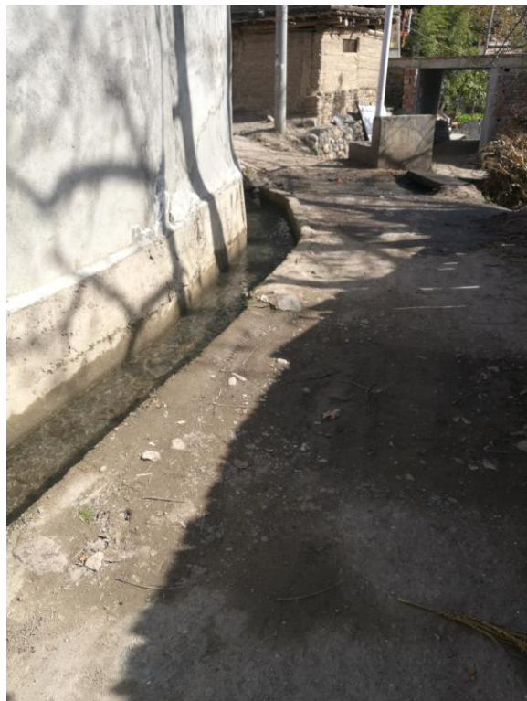
道路与排水现状
