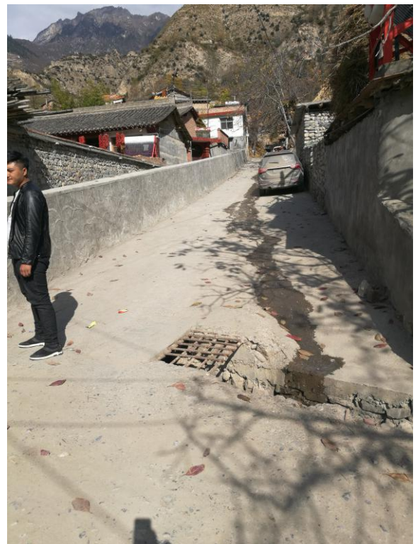
道路与排水现状
