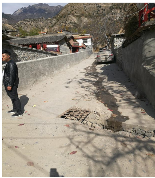
现有硬化道路及排水现状
