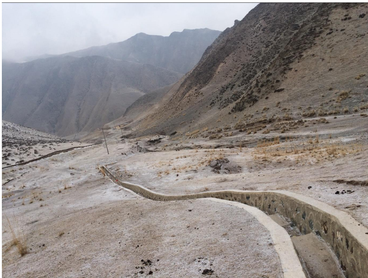
图 2.1-4 现状填埋场外截洪渠
