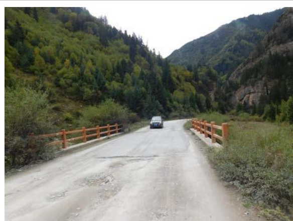
K14+580 益哇沟 4 号桥为 1-13m 钢筋混凝土空心板
