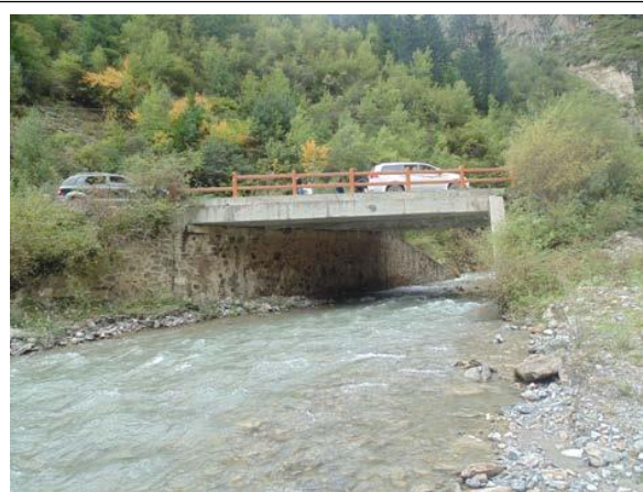
13+640.3 益哇沟 3 号桥为 1-13m 钢筋混凝土空心板
