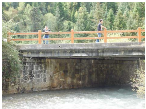
K18+559.7 益哇沟 7 号桥为 1-13m 钢筋混凝土空心板
