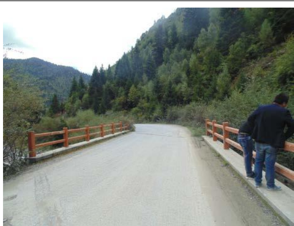
13+640.3 益哇沟 3 号桥为 1-13m 钢筋混凝土空心板
