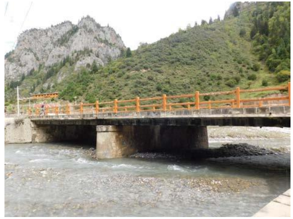
K17+040.7 益哇沟 5 号桥为 2-13m 钢筋混凝土空心板
