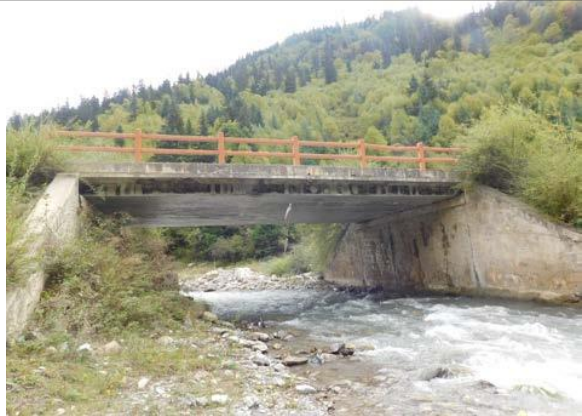
13+640.3 益哇沟 3 号桥为 1-13m 钢筋混凝土空心板
