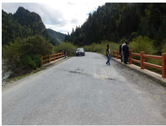
K18+559.7 益哇沟 7 号桥为 1-13m 钢筋混凝土空心板
