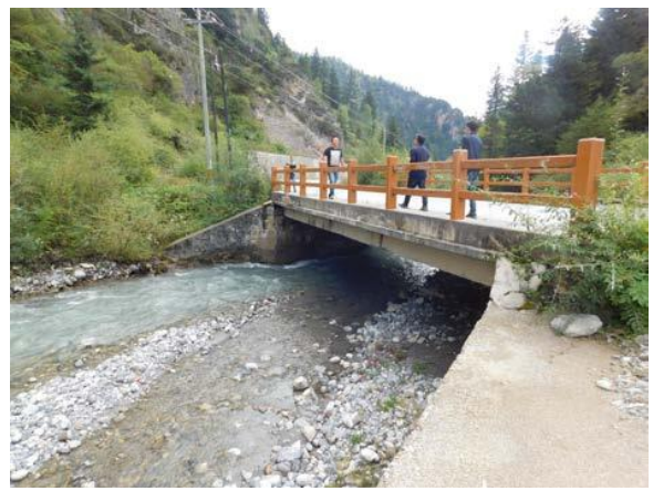
K17+741.7 益哇沟 6 号桥为 1-13m 钢筋混凝土空心板
