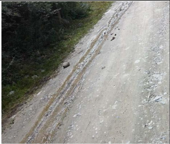
旧路面破损严重路段
