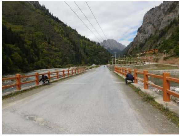
K17+040.7 益哇沟 5 号桥为 2-13m 钢筋混凝土空心板
