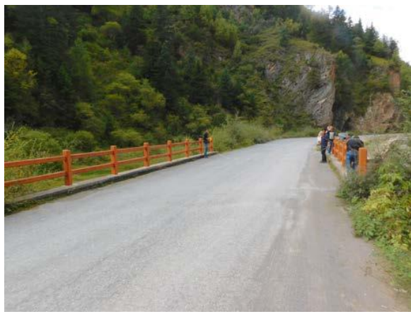
K17+741.7 益哇沟 6 号桥为 1-13m 钢筋混凝土空心板
