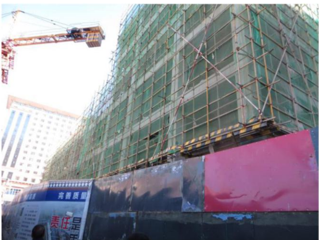
项目东侧施工工地
