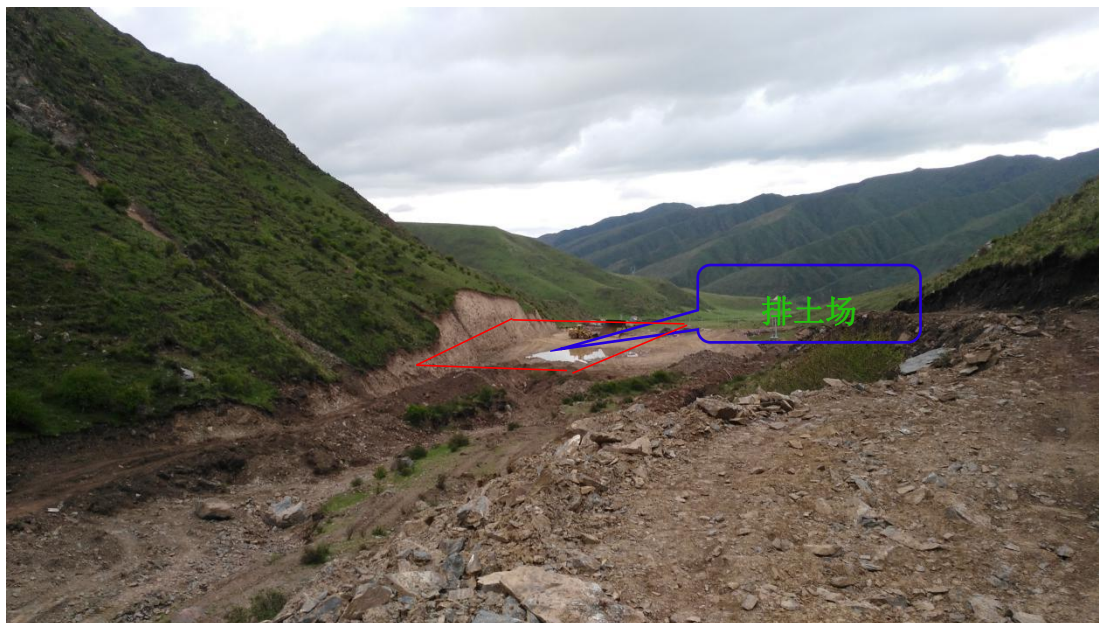
图 2.3.14-1 本项目排土场现状图
