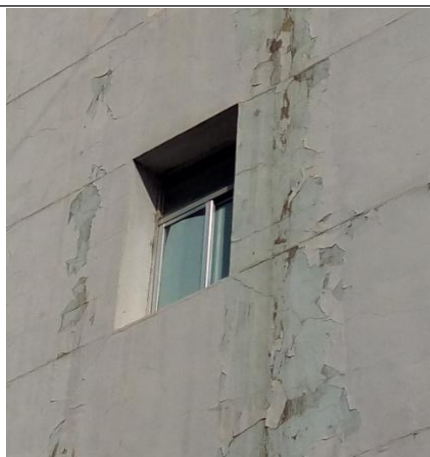
舟曲县瓦厂拆迁安置 2#住宅楼墙面现状
