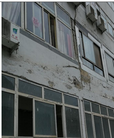
舟曲县瓦厂拆迁安置 5#住宅楼现状
