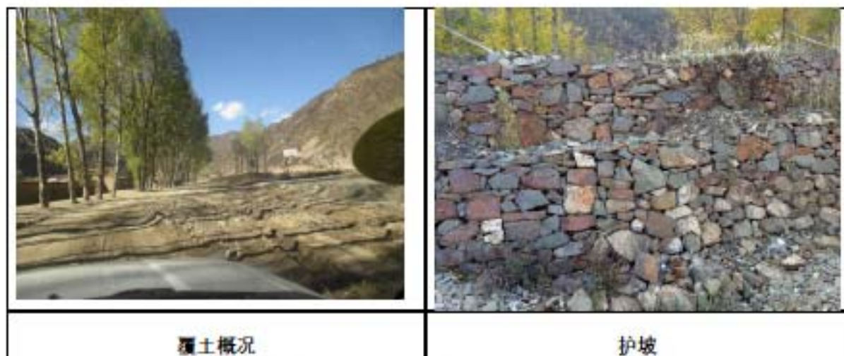
图 5-1 多架水电站渣场情况
