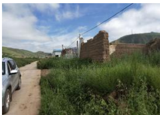
无照明设施，无人行道，路面破损
