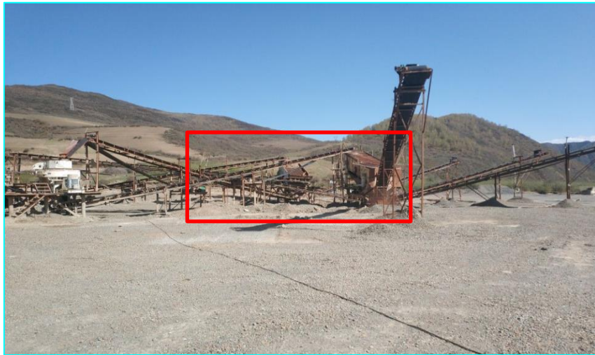
筛分机（新址工业场地）
