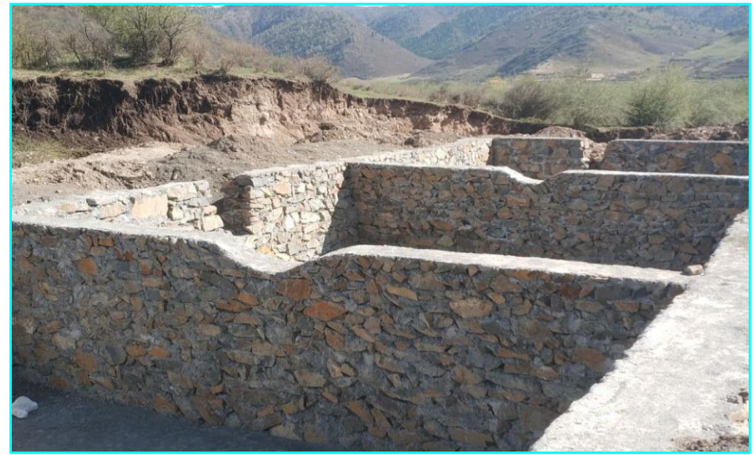
沉砂池（新址工业场地）
