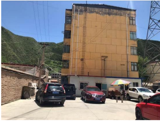
7、广电家属楼，塔南约 5 m
