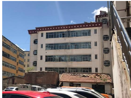
10、检察院家属楼，塔西约 20 m
