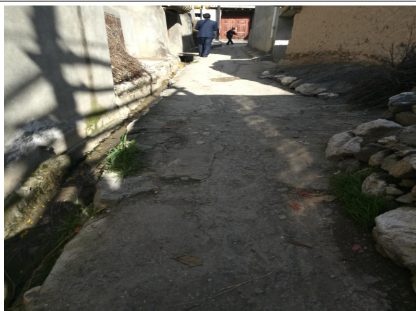
现状道路及排水渠
