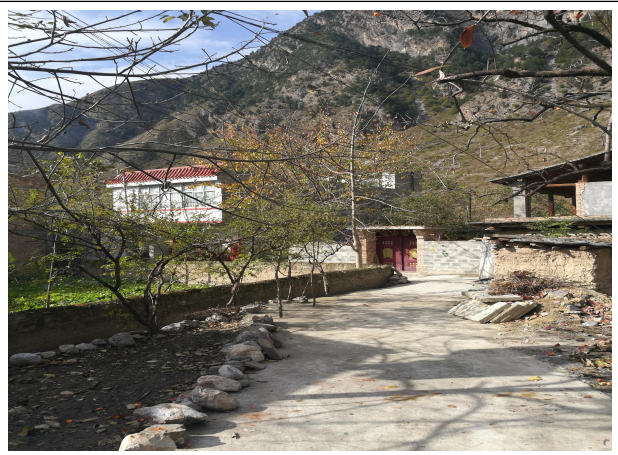
现状硬化道路
