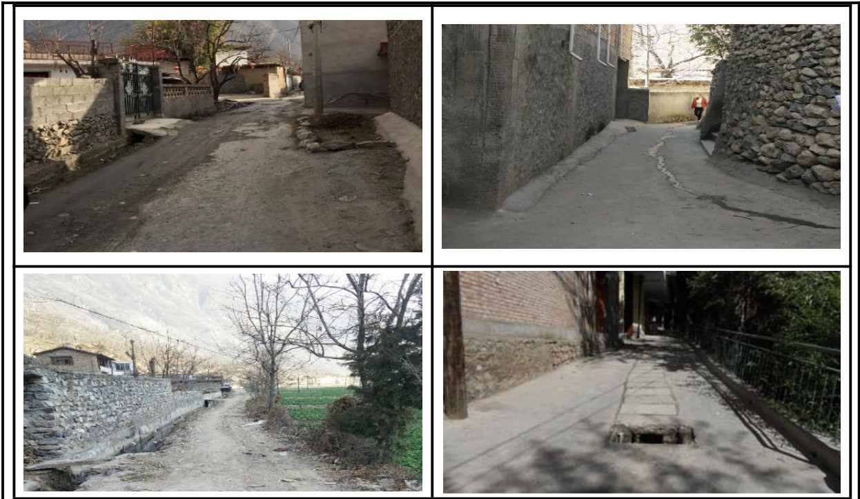
图 1 舟曲县峰迭镇武都关片区道路及排水现状
