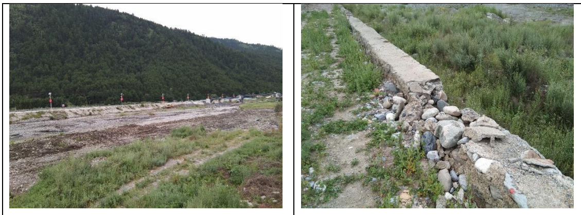
图 3-1 县城段堤防现状
