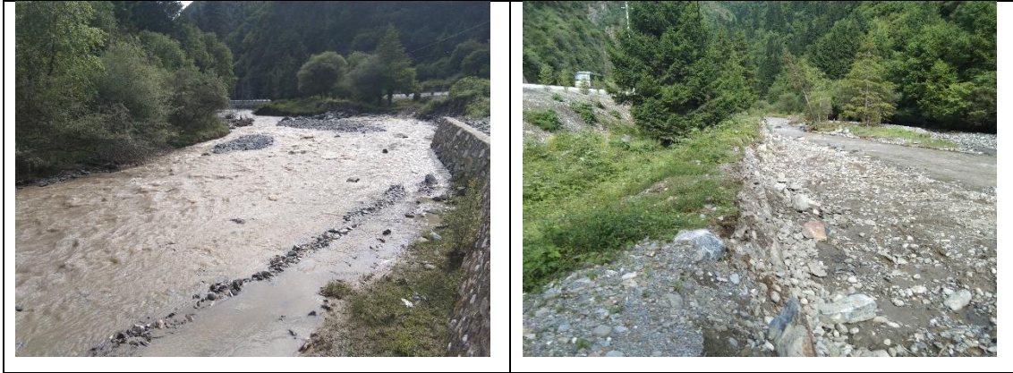
图 3-2 益哇沟段防洪工程现状
