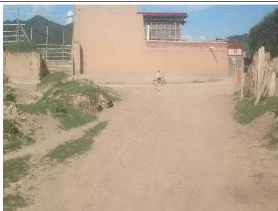
项目区道路路面
