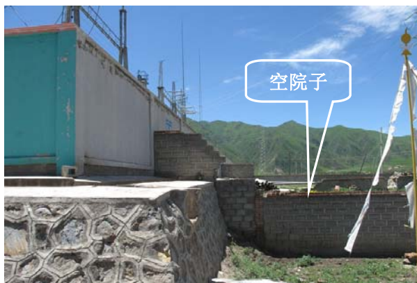
站界北侧现状
