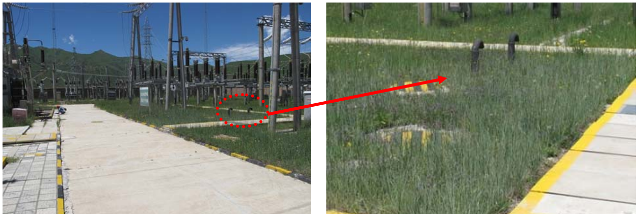
图 9-5 碌曲变站内事故油池
