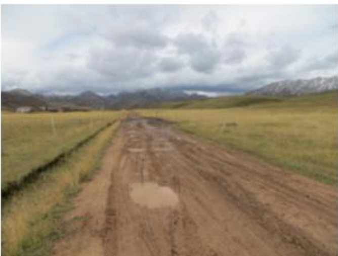
现有部分砂砾路
