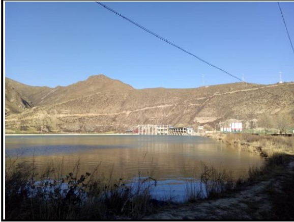
右岸起点河道现状（多架山水库）
