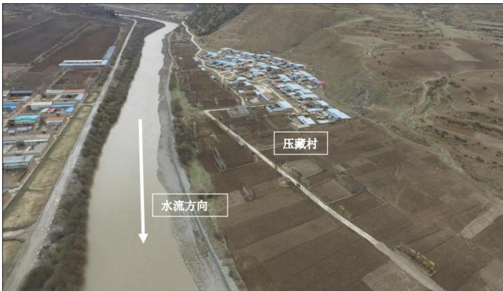
图 1-2 压藏桥桥址左岸
