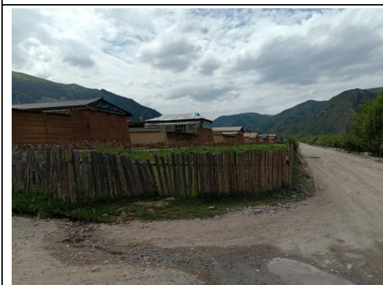
项目南侧双岔村
