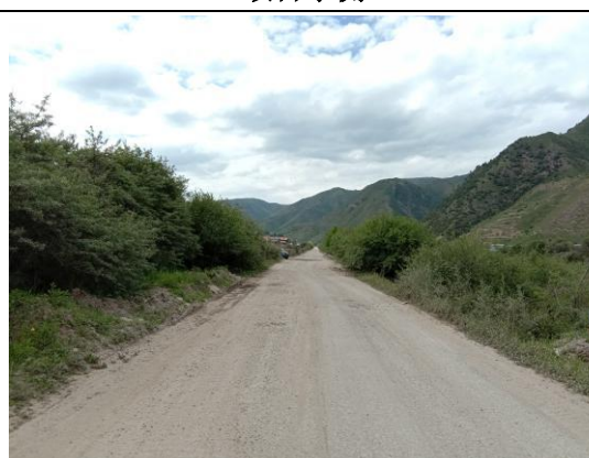
项目建设南侧 X402 县道
