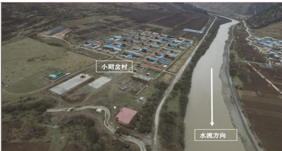
图 1-3 压藏桥桥址右岸
