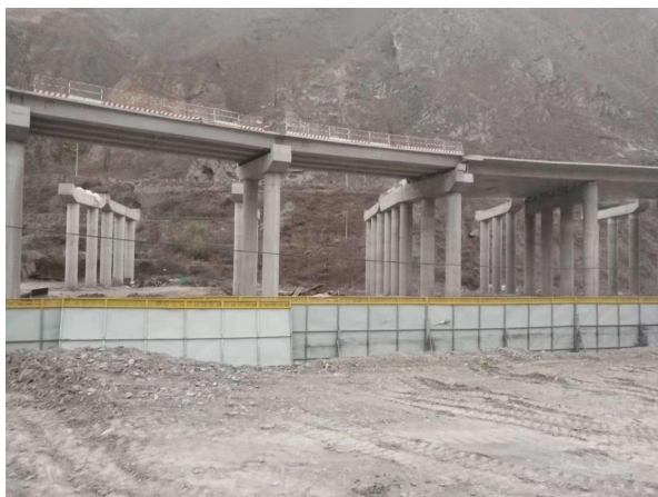
项目南侧在建高速公路
