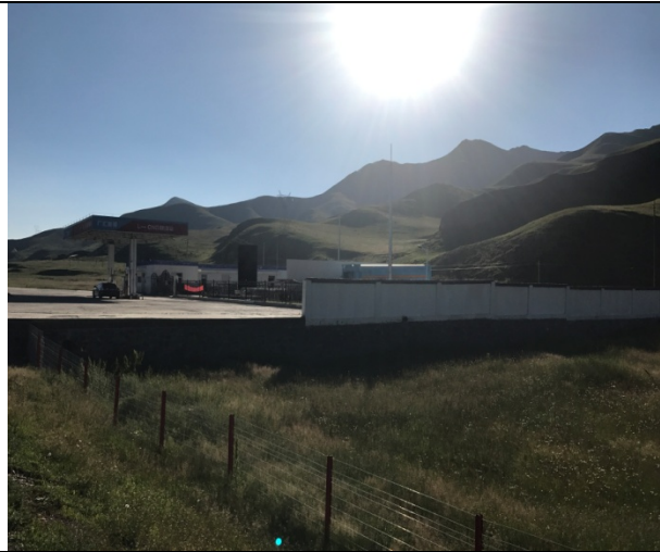
项目西侧加气站现状
