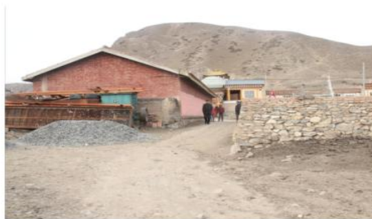
项目区道路路面
