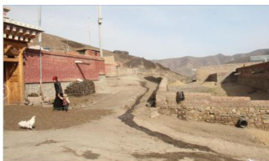
项目区道路路面
