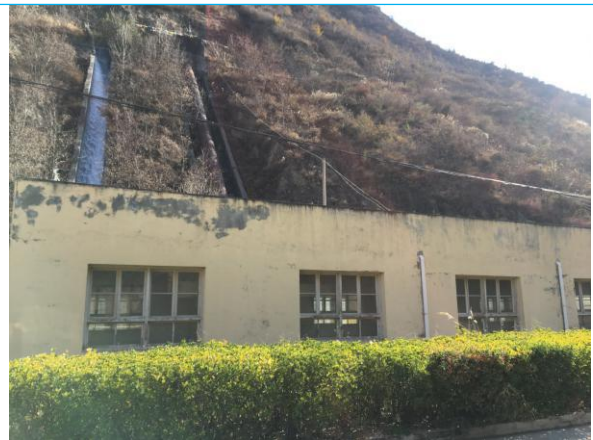
铁坝电站厂房区
