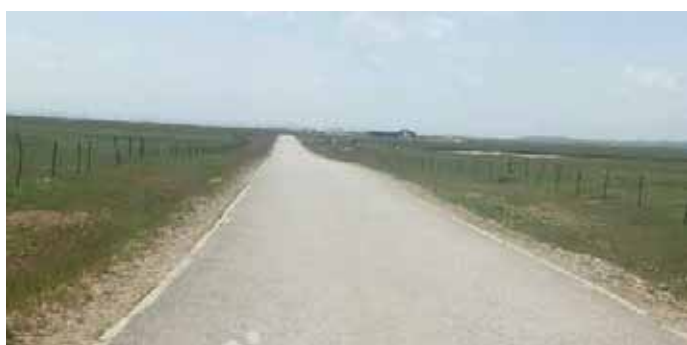
道路终点现状
