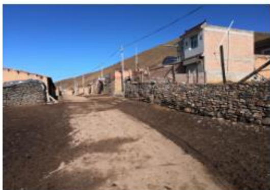
项目区道路路面
