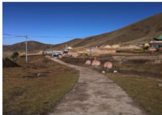
项目区道路路面
