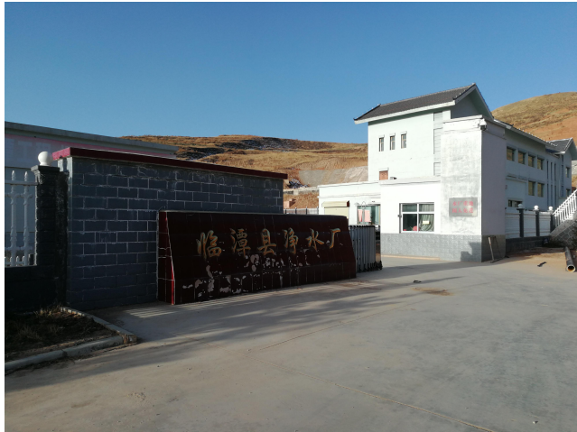
临潭县净水厂
