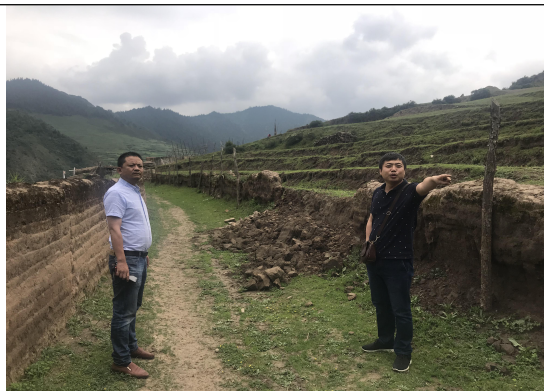
项目区道路路面
