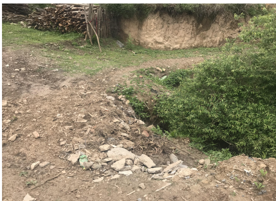
项目区道路路面
