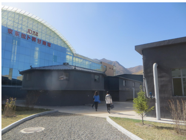
依托污水处理站
