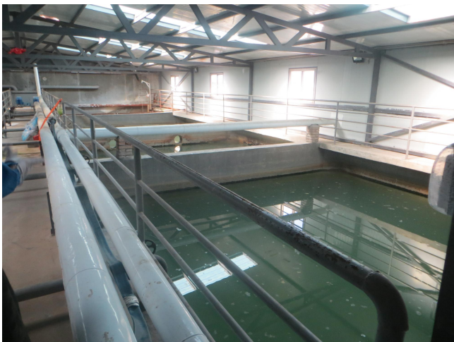
依托污水处理站
