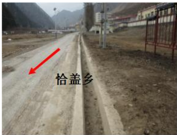
现状排水沟及路面
