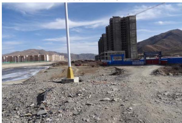
团结南路—在建海螺湾城市综合体住宅
