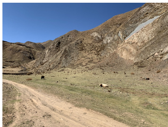
项目区道路路面
