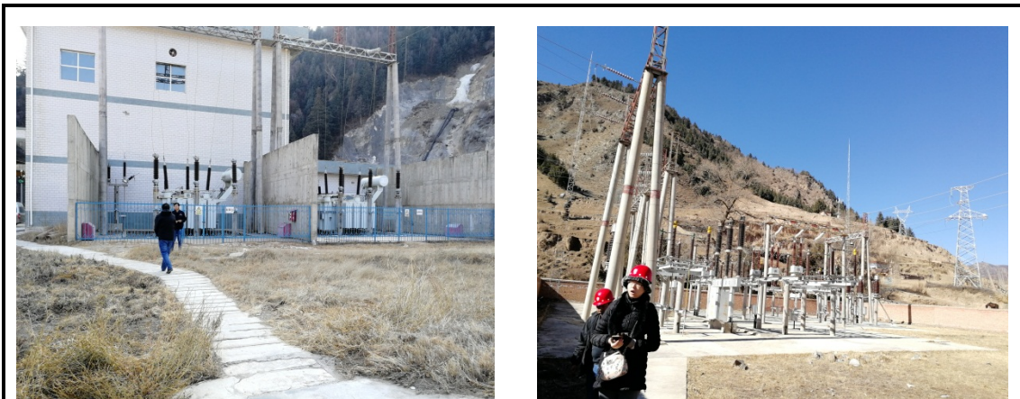
图 7-1 升压站、开关站站内及站址周围生态恢复图
