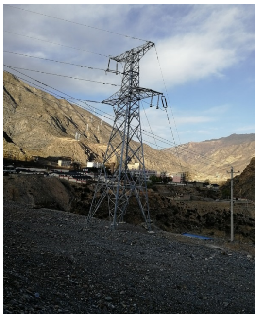
水电站建设用 地
