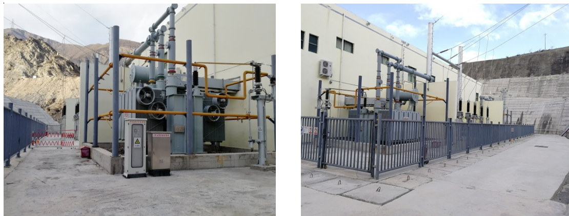
图 7-1 升压站站内及站址周围情况
