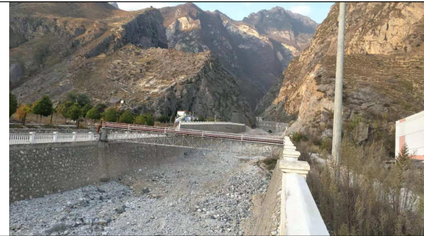
道路西侧三眼峪沟
