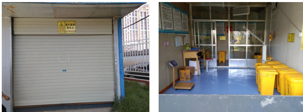
图 4 医疗废物暂存间
