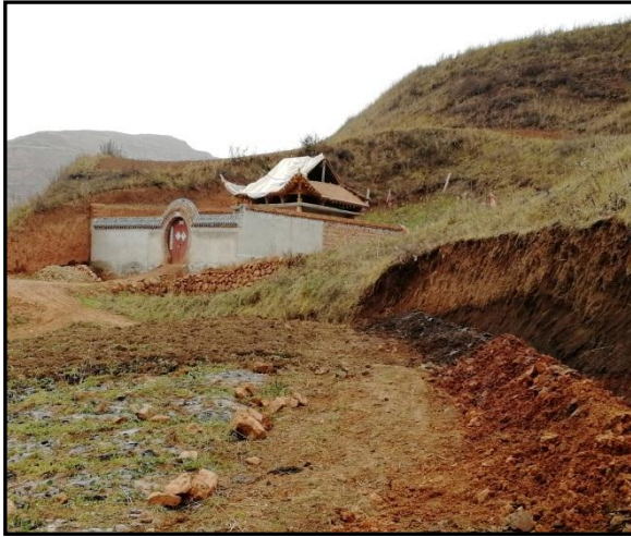
项目厂区现状（龙王庙）
