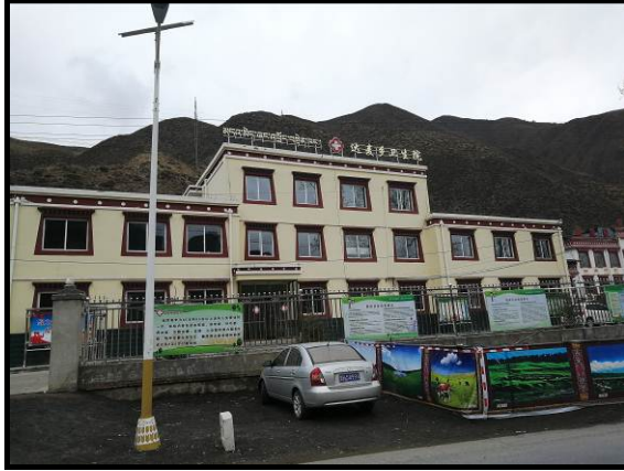
与厂区隔墙而建的卫生院
