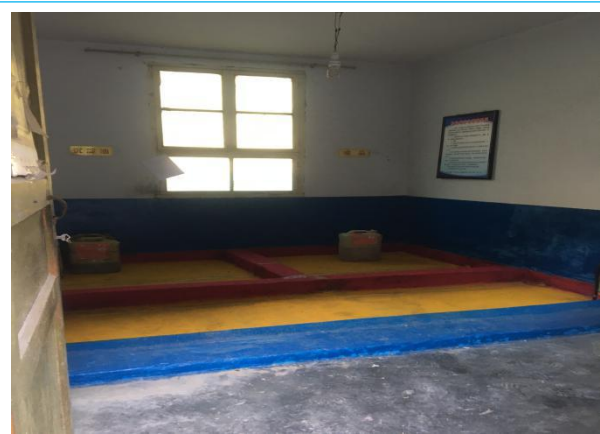
危废暂存间防渗
