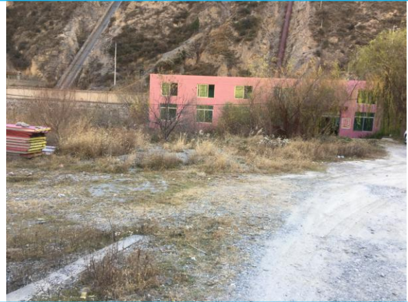
丁字河口电站厂房区
