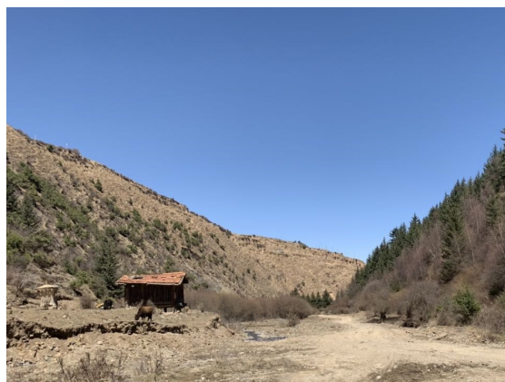
项目区道路路面
