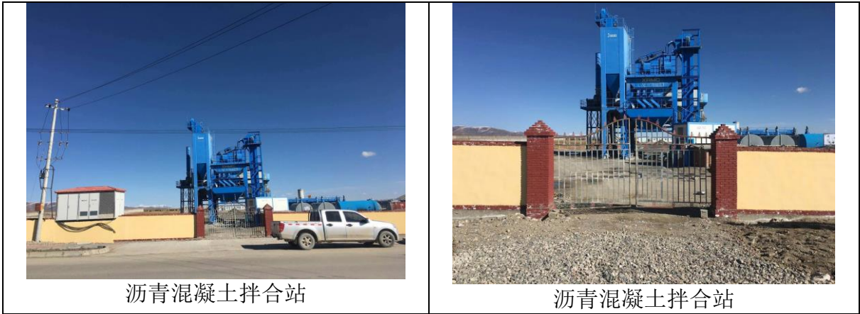
图3.2-5 依托工程现状
